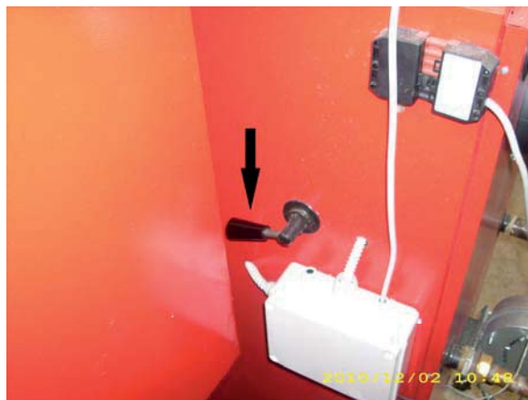
Рисунок 12. Положение ручки клапана «РАБОТА»
