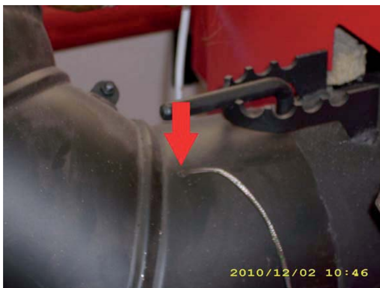
Рисунок 6. Установка датчика температуры уходящих газов
