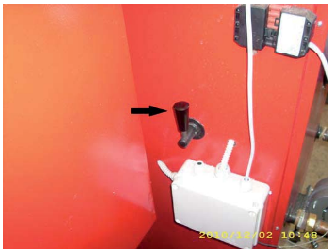
Рисунок 9. Положение ручки клапана «ПОДЖИГ»
